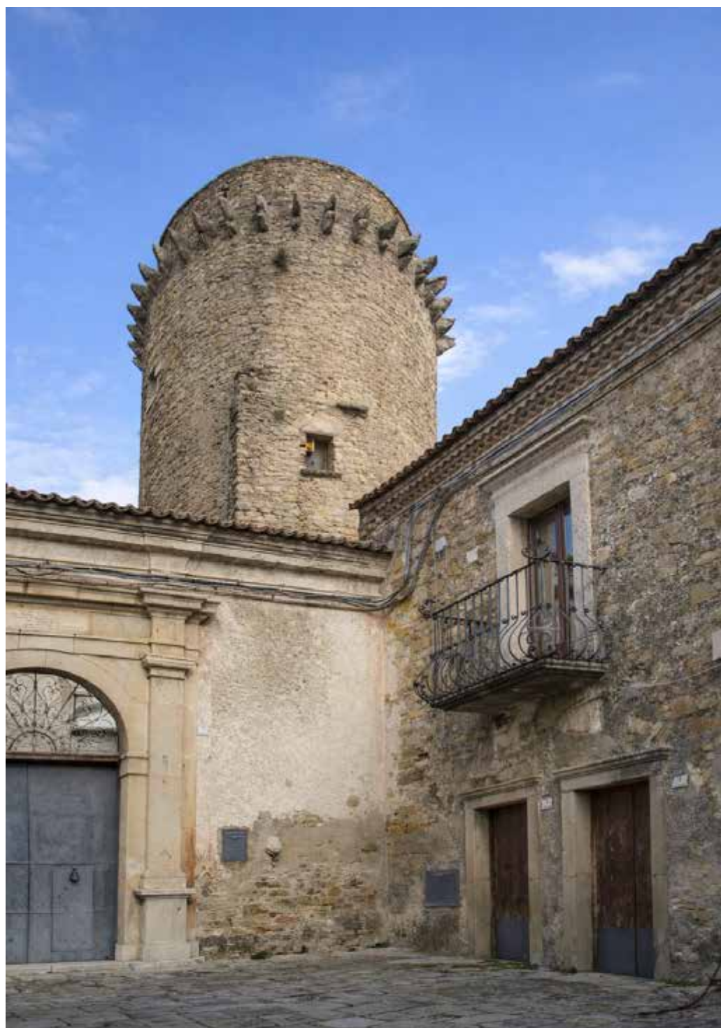
Fig. 15: Portale di ingresso del castello e vista della torre.
